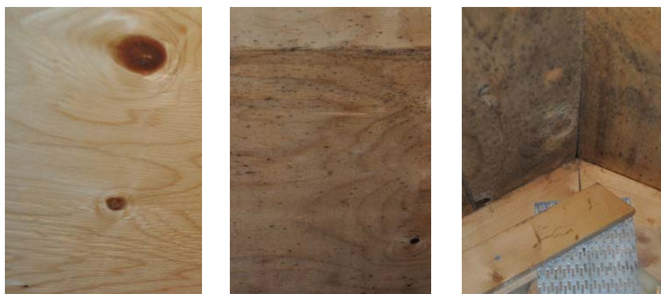
Figur 2 Olika grader av mögelpåväxt på underlagstak av plywood. Tv: MI < 3, mitten: MI ca 4, högra bilden: MI ca 6 (fri tolkning). Bilder tagna på testkallvindar på SP i Borås, höst 2012. Foto: A Sasic.
